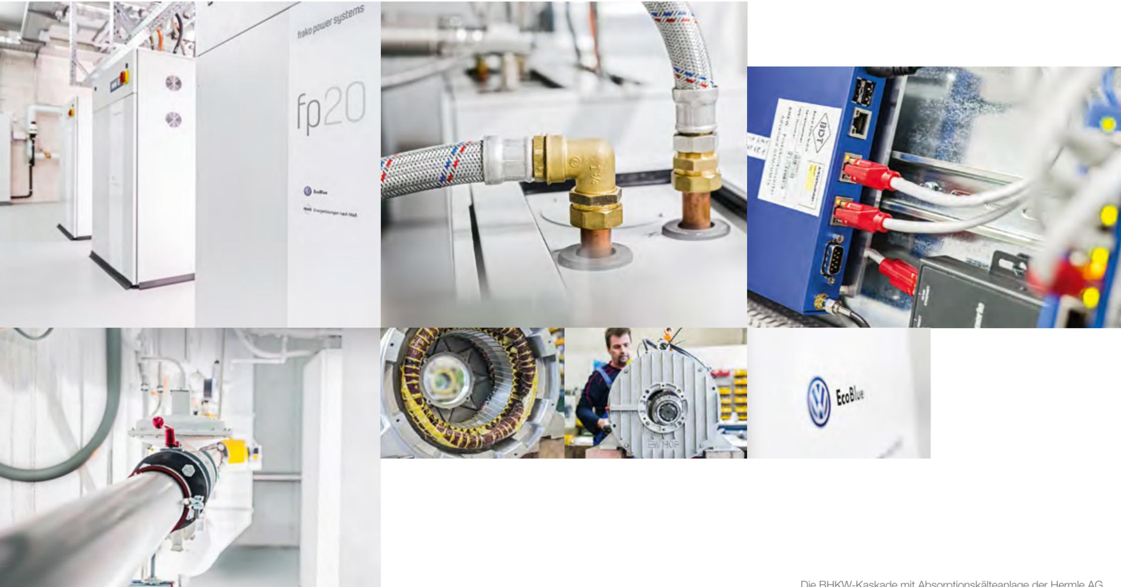
Die BHKW-Kaskade mit Absorptionskälteanlage der Hermler AG ist ein gutes Beispiel für das gelungene Zusammenspiel von Kompetenzen innerhalb der AdCapital-Gruppe. Die Anlage sorgt zukünftig das ganze Jahr über für die optimale Klimatisierung der neuen Montagehalle. Die Energiekosten werden optimiert, indem aus einem gekoppelten System Wärme, Kälte und eigener Strom erzeugt werden.
